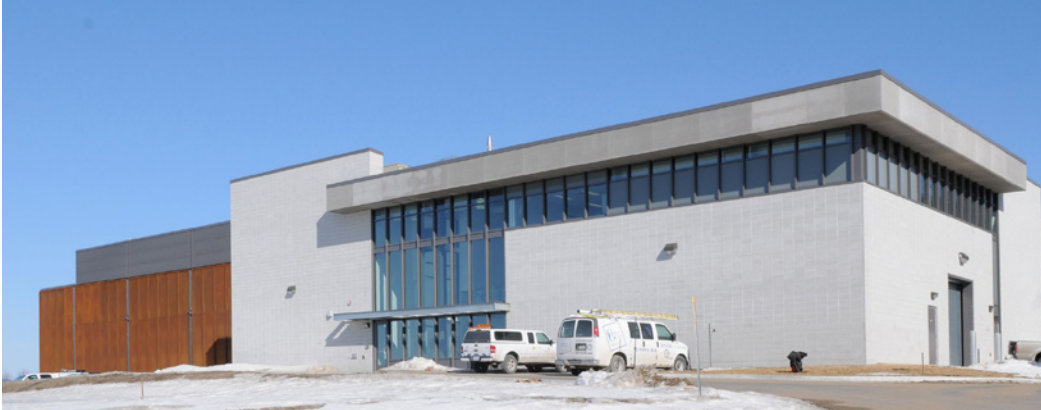
Photo extérieure de l'usine de traitement de l'eau potable (UTE) de Charlesbourg
